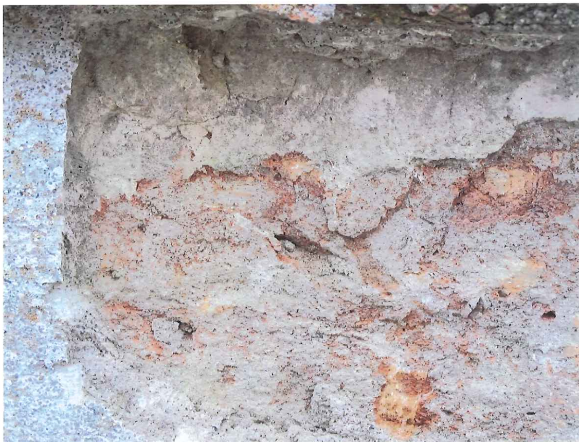
Fot. 32 Odkrywka na powierzchni fryzu na elewacji wschodniej, fragmenty oryginalnej wyprawy tynkarskiej pod warstwą wtórnych tynków, październik 2023 r.
