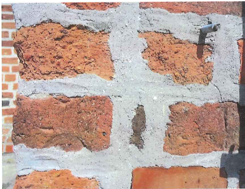
Fot. 1 Fragment wtórnych spoin na ceglany licu kościoła
