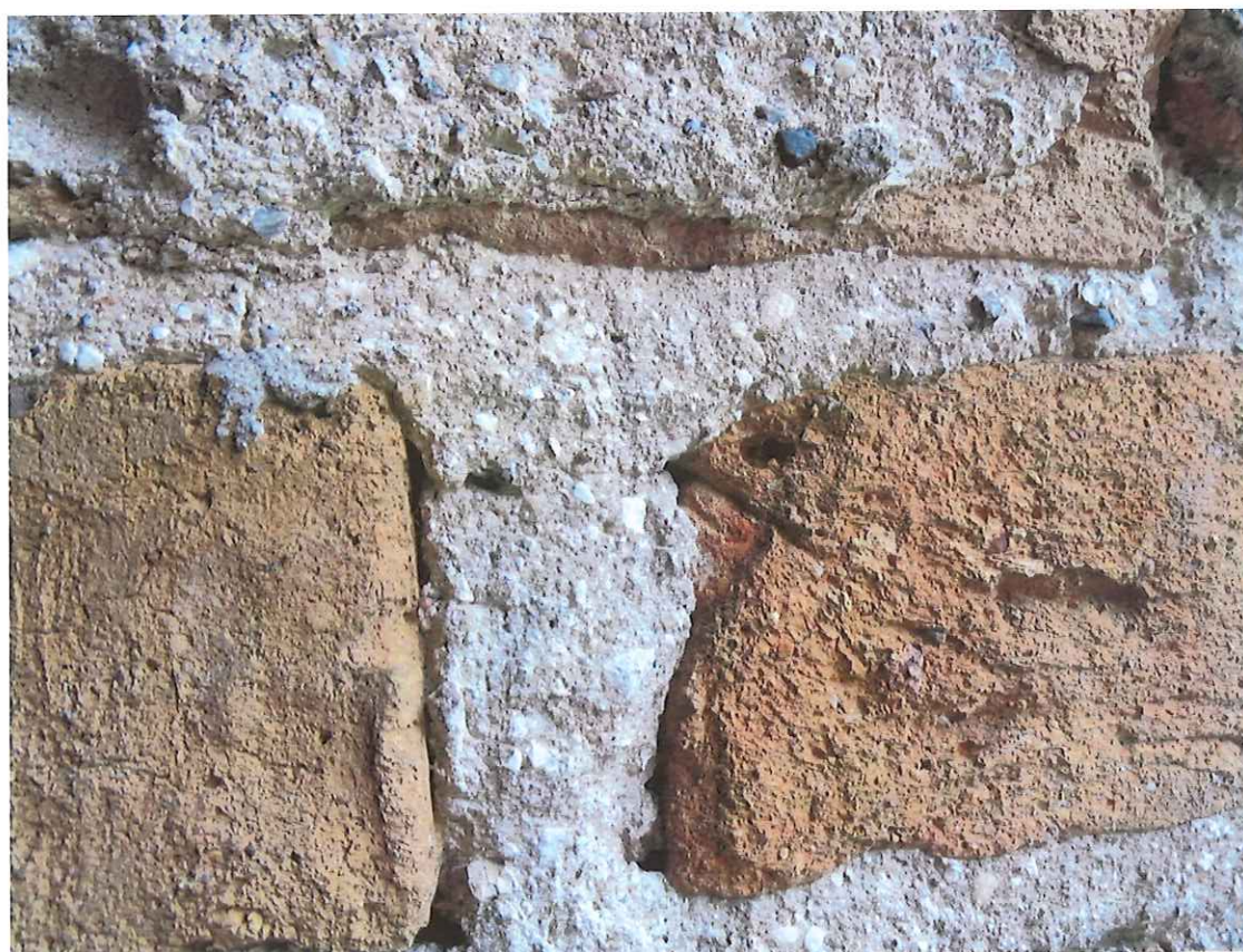
Fot. 30 Fragment zachowanej oryginalnej spiny w ościeżu okna wieży kościoła, październik 2023 r.
