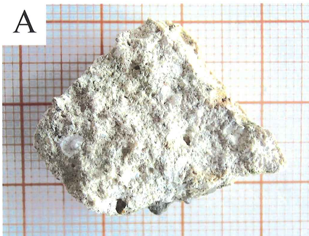
Fot. 1. Próbką A – zaprawa spoinująca, miejsce pobrania: ościeże okna na elewacji zachodniej wieży kościoła.
