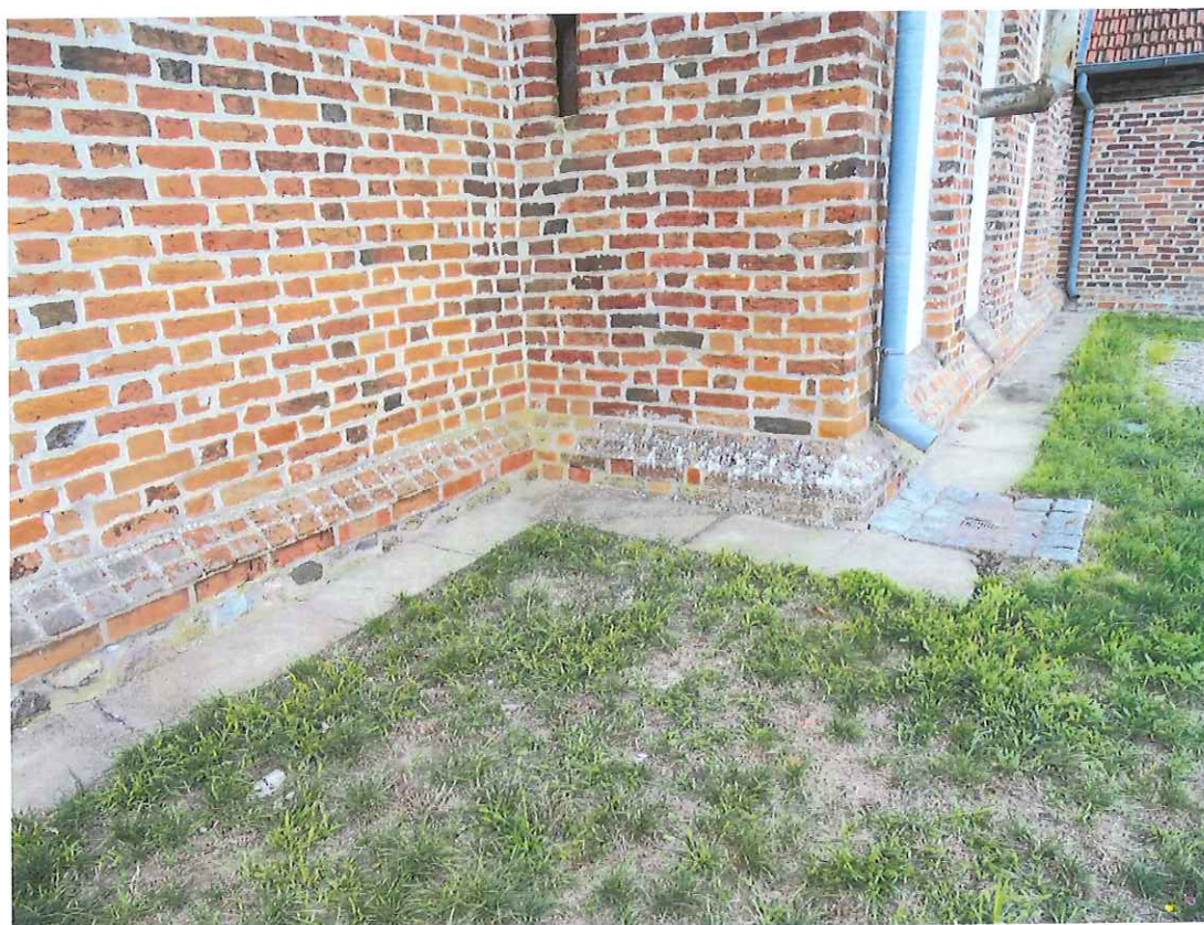
Fot. 19 Fragment południowych elewacji wieży i korpusu nawowego z betonową wylewką, sierpień 2023
