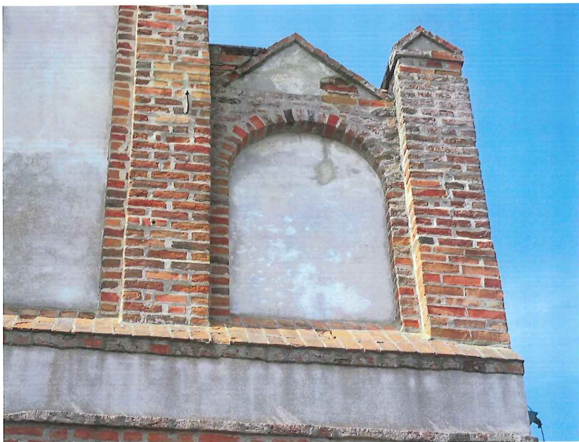
Fot. 15 Fragment szczytu wschodniego kościoła, górna blenda od strony północnej, sierpień 2023 r.
