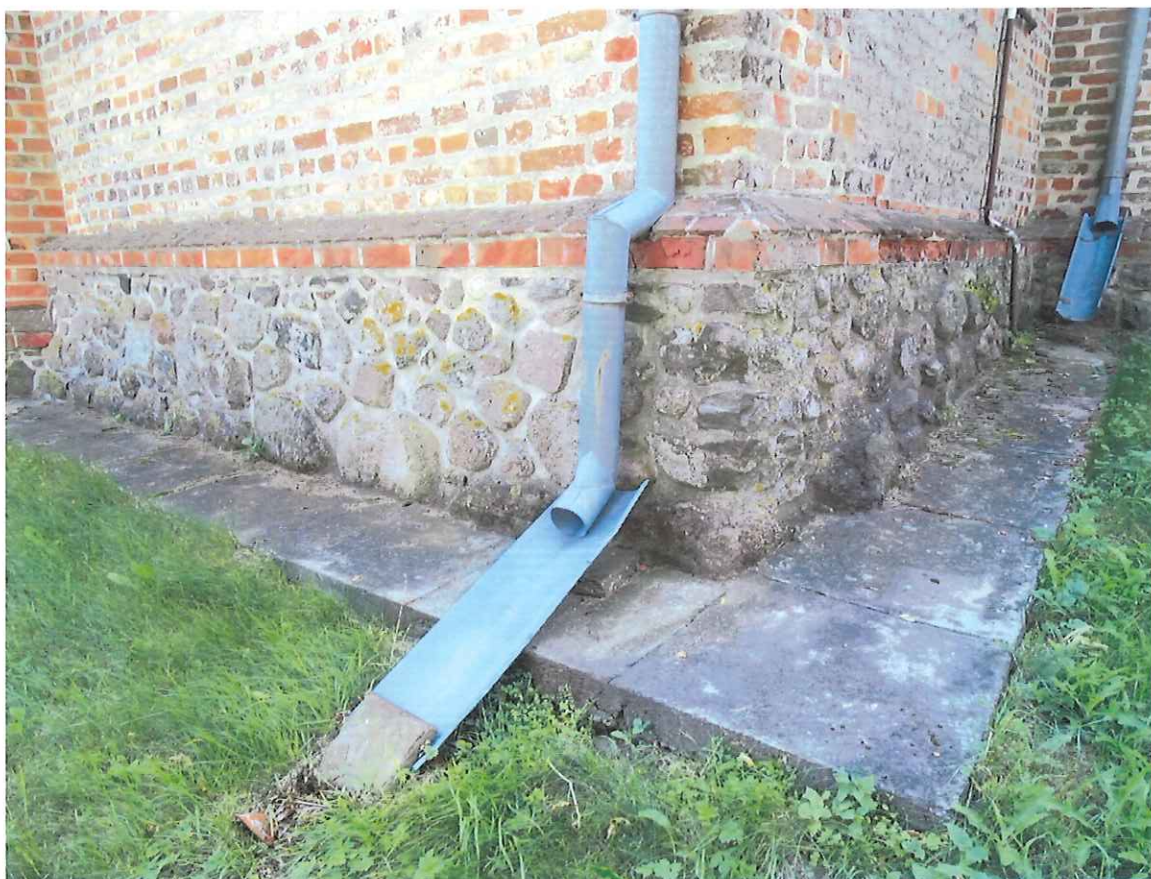
Fot. 28 Fragment dolnej strefy elewacji zakrystii kościoła, sierpień 2023 r.
