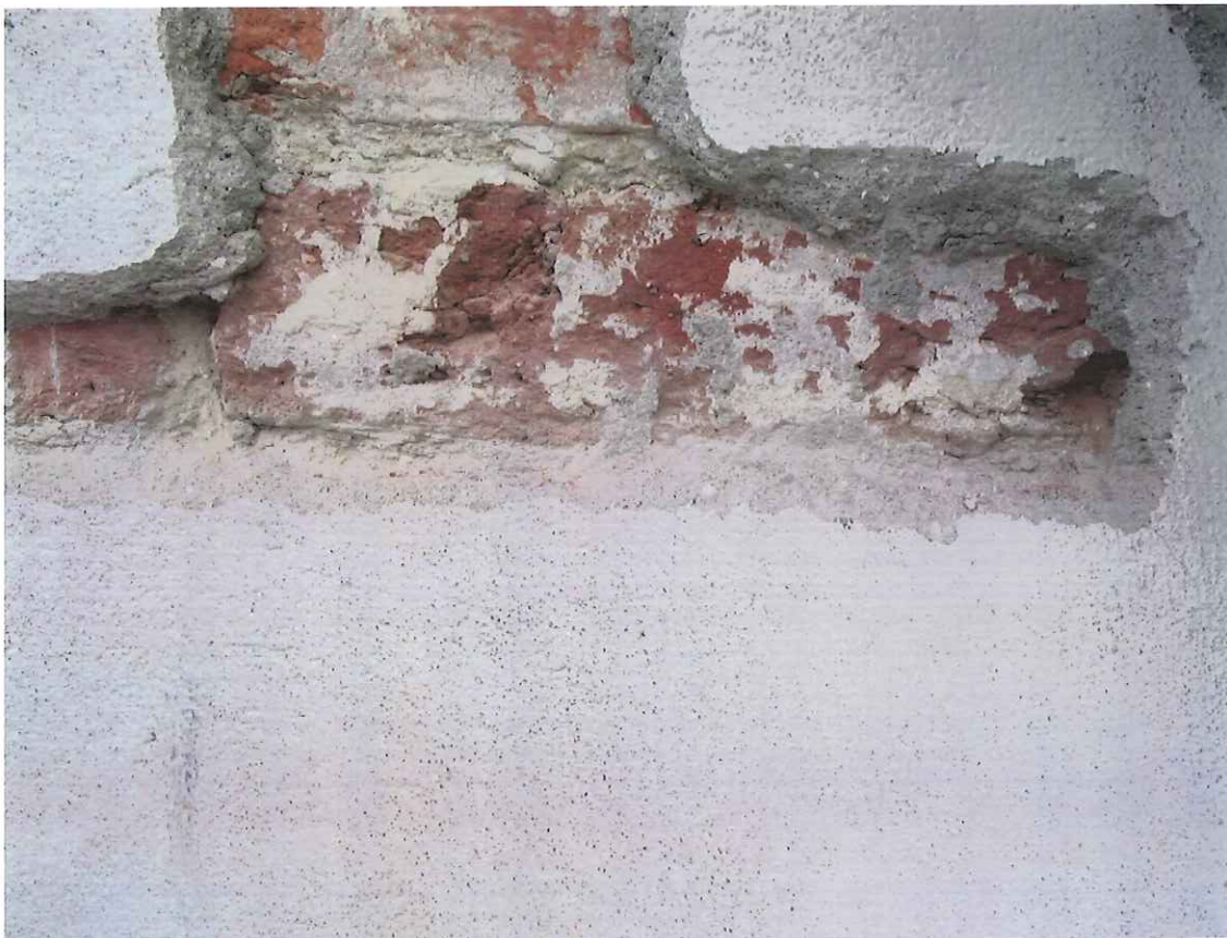
Fot. 31 Odkrywka na powierzchni blendy na elewacji południowej, ślady oryginalnej wyprawy tynkarskiej pod warstwą wtórnych tynków, październik 2023 r.
