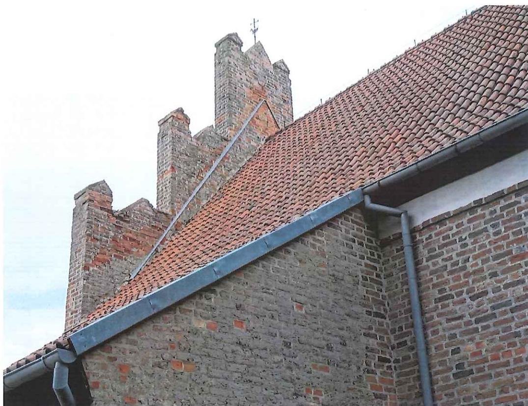
Fot. 17 Szczyt wschodni od strony dachu kościoła, widoczna pierwotna wysokość dachu, sierpień 2023 r.
