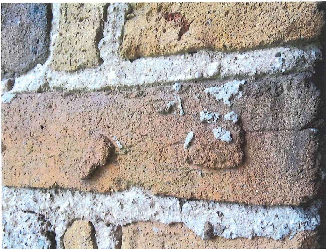
Fot. 29 Fragment zachowanej oryginalnej spiny w ościeżu okna wieży kościoła, październik 2023 r.
