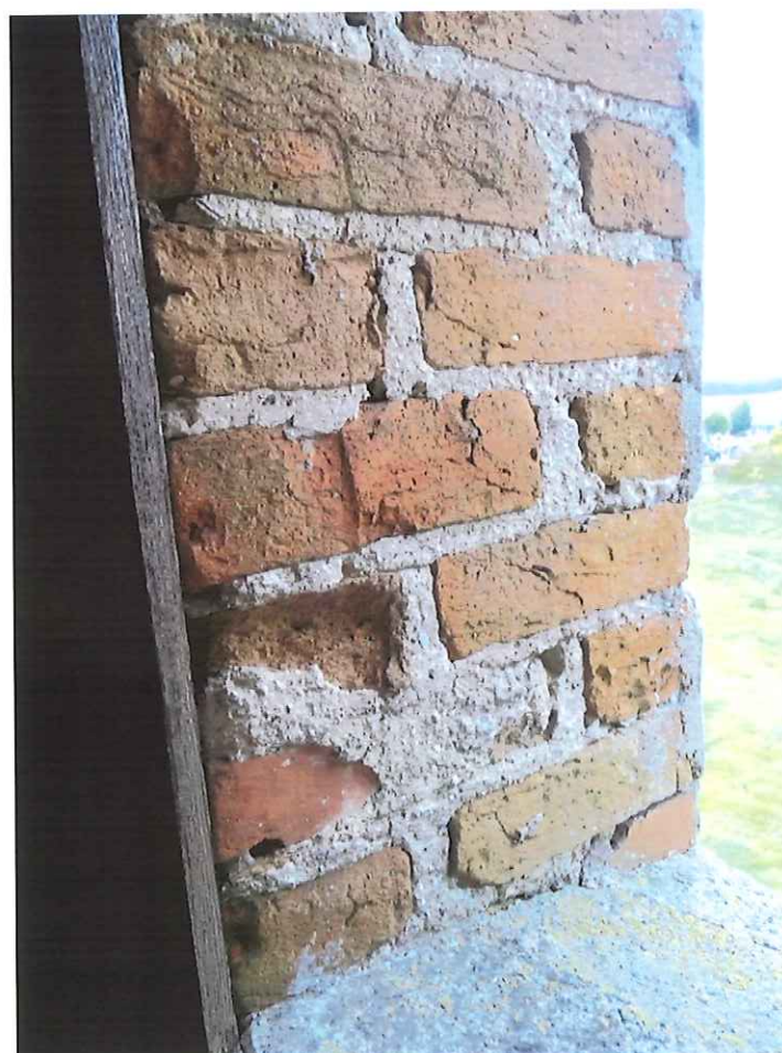
Fot. 3 Fragment zachowanych oryginalnych spoin na ceglanym licu, ościeże okna na zachodniej elewacji wieży kościoła.
