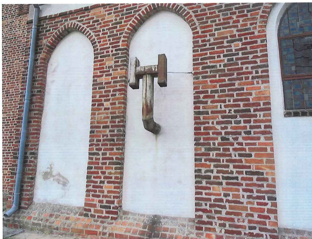
Fot. 18 Fragment elewacji południowej korpusu nawowego kościoła z wtórnym kominem, sierpień 2023 r.
